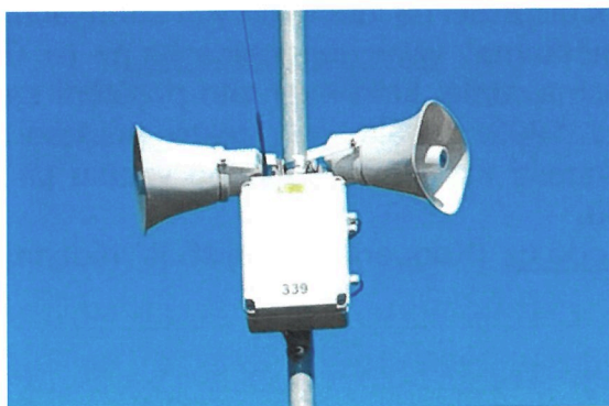
Obrázek 36: Příklad bezdrátového hlásiče
