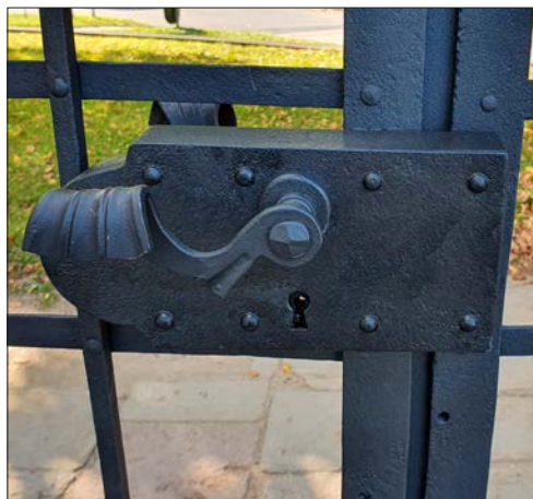
Detail brány po opravě
