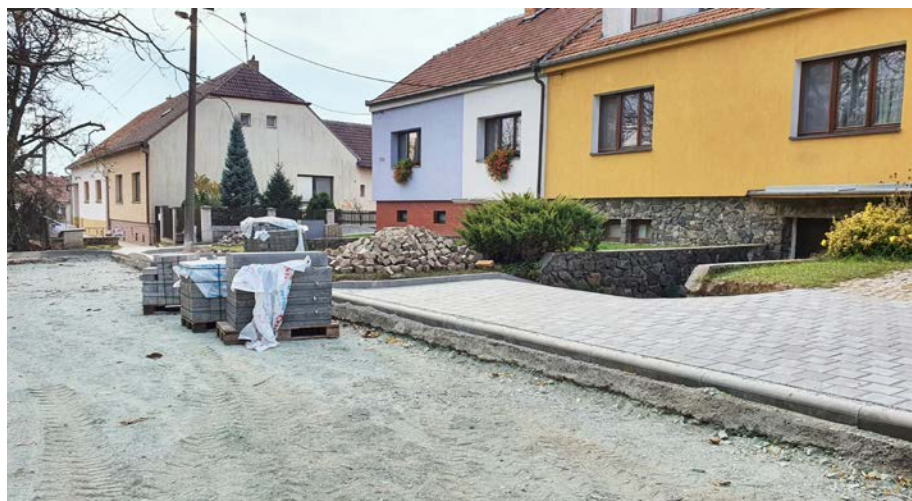
Probíhající rekonstrukce Rajhradské ulice
