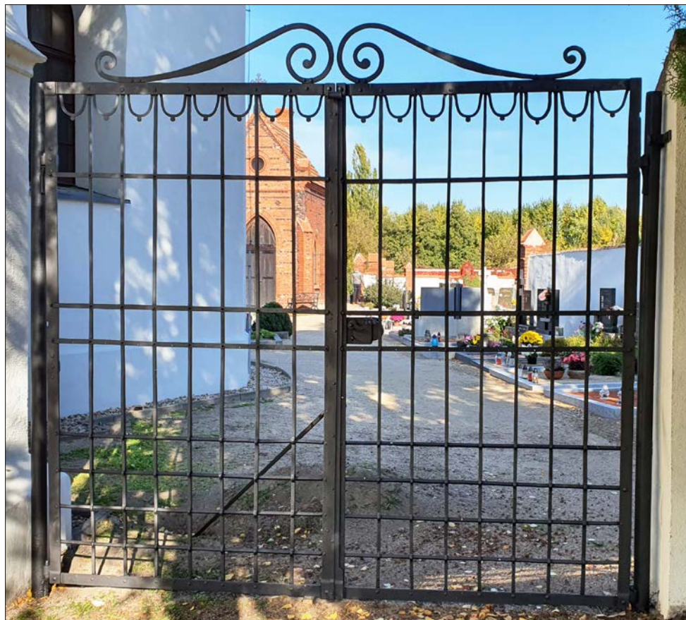
Vstupní brána na hřbitov po opravě
