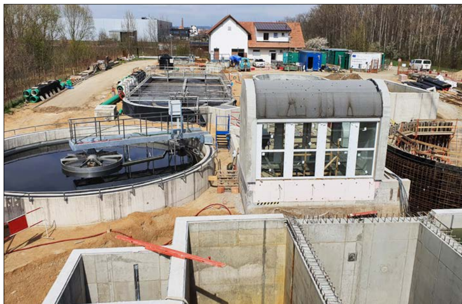
Čistírna odpadních vod
