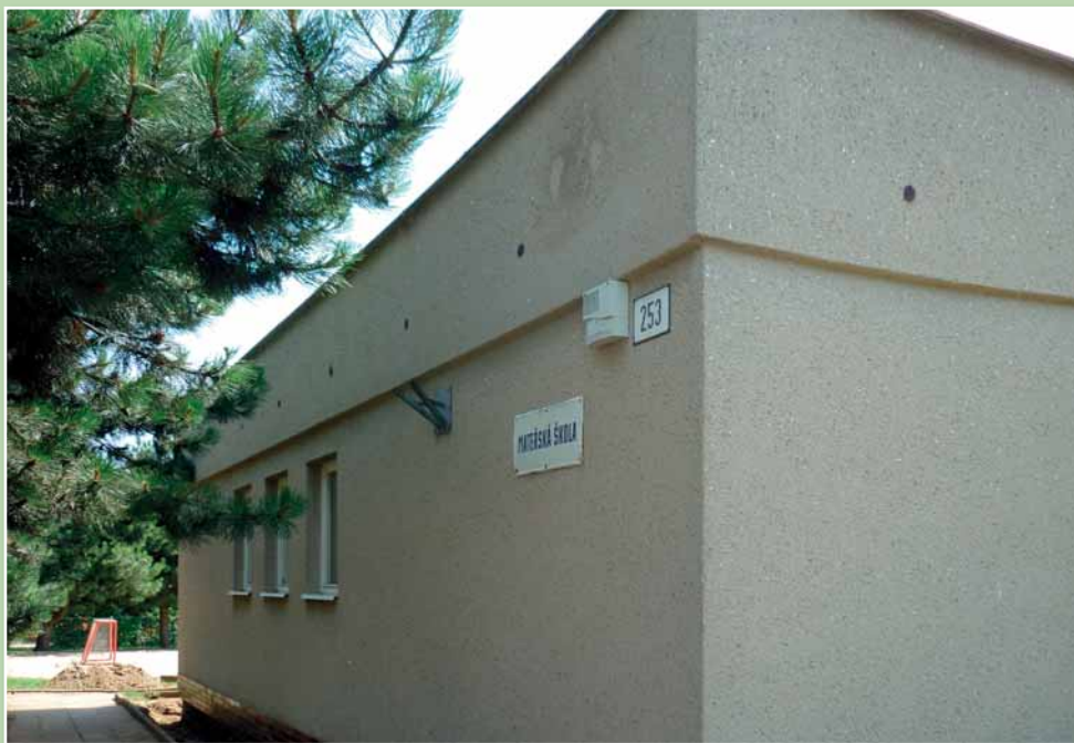
Detail budovy mateřské školy před rekonstrukcí
