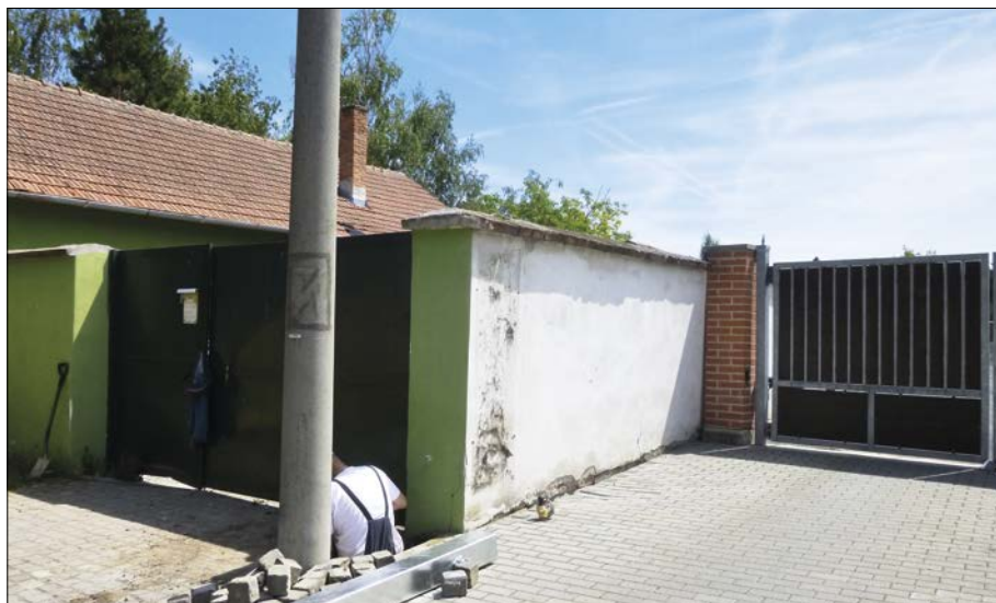
Původní stav – staticky narušená zeď opírající se pilíř sousední brány.
