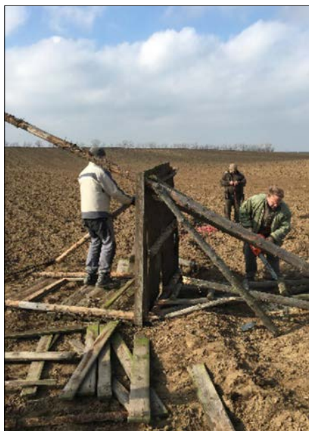
Rozebrání starého posedu
