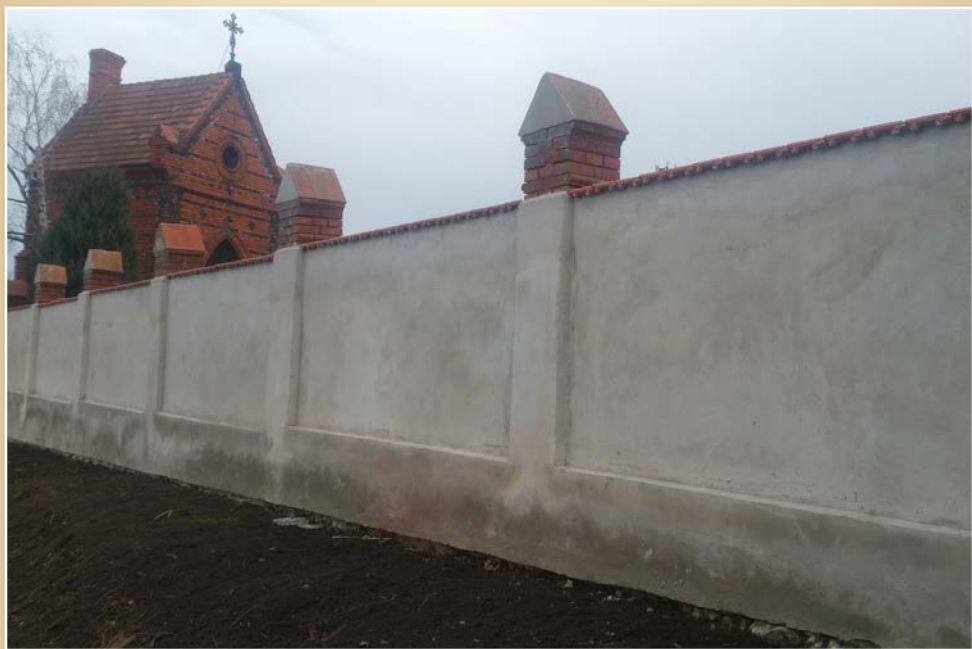
Hřbitovní venkovní zeď po opravě
