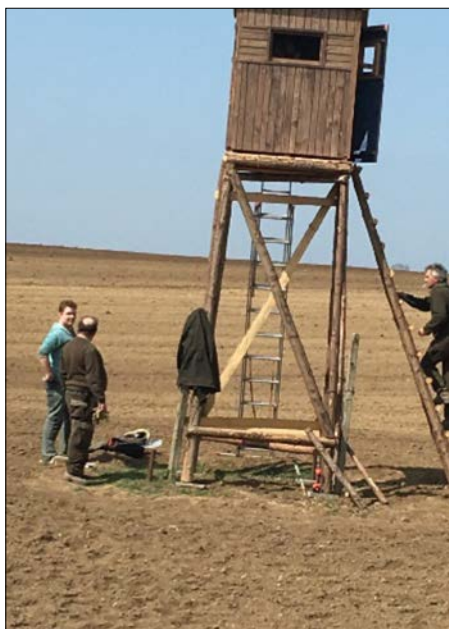
Postavení nového posedu
