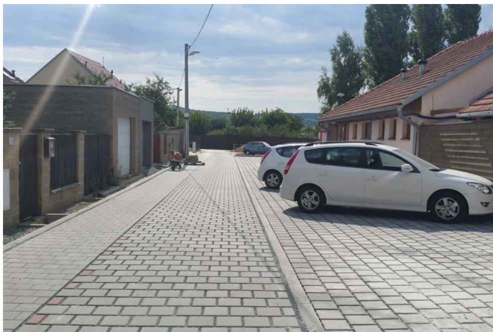
Ulice Sportovní po rekonstrukci
